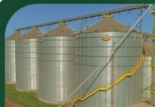
Silos, estruturas elevadas, galpões e telhados
